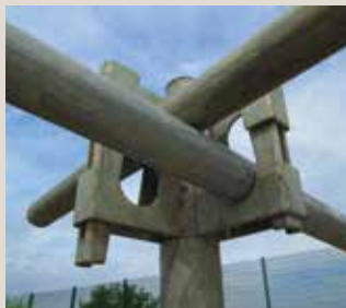
Fig. 20 Potelet multidirectionnel à clavettes
