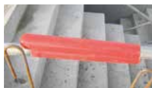
Fig. 22 Extrémité de lisse avec manchon PVC
