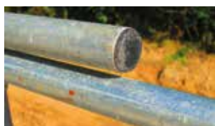
Fig. 21 Extrémité de lisse avec bouchon PVC
