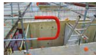
Fig. 24 Jonction de lisses dans un accès par échelle
