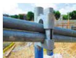
Fig. 17 Support de lisses à clavette
