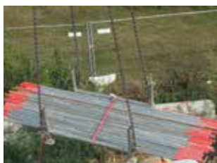
Fig. 28 Sanglage de lisses sur panier non fermé
