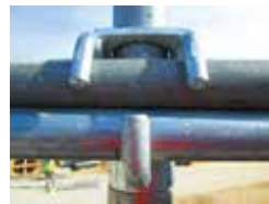
Fig. 16 Support de lisses à pince
