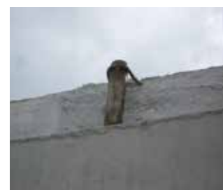
Fig. 13 Fourreau en acier pour mur précoffré
