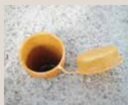
Fig. 4 Fourreau en PVC noyé dans le béton
