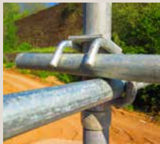
Fig. 19 Potelet multidirectionnel à pinces
