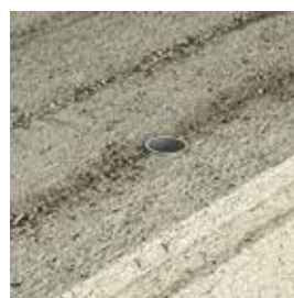
Fig. 12 Fourreau en PVC pour dalle alvéolaire
