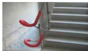
Fig. 23 Jonction de lisses dans un escalier
