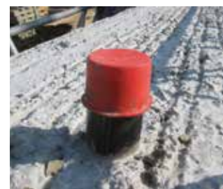
Fig. 11 Fourreau en acier pour prédalle
