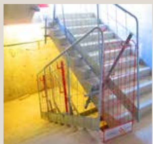
Fig. 4 Pince fixée sur structure oblique
