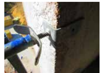
Fig. 18 Dispositif de serrage à équerres
