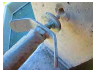
Fig. 17 Dispositif de serrage à tétons
