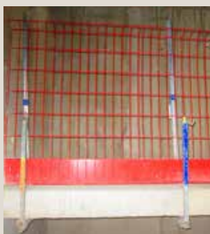
Fig. 2 Pince fixée sur structure horizontale
