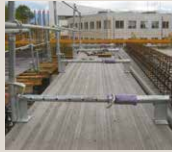
Fig. 11 et 12 Systèmes à serrage sur la largeur de la dalle alvéolaire
