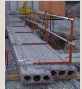
Fig. 11 et 12 Systèmes à serrage sur la largeur de la dalle alvéolaire
