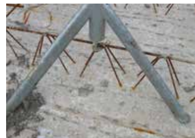
Fig. 8 Ancrage sur raidisseur à treillis d'une prédalle
