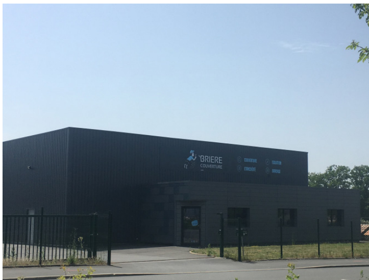
Site de Brière Couverture
